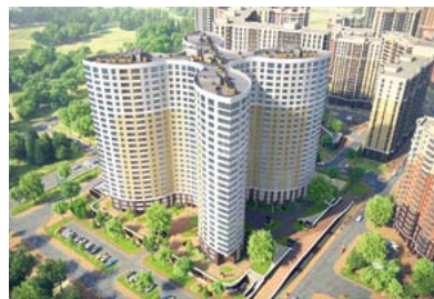
ЖК «Архитектор» г. Кудрово, микрорайон Новый Оккервиль
