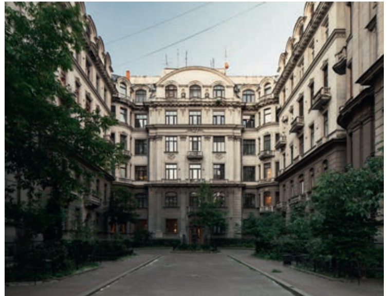
4. Жилой дом 3-го Петроградского товарищества собственников квартир
