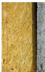
Утеплитель наружных стен из минеральной ваты
