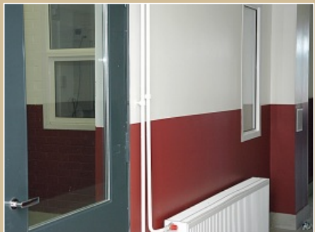
Двери в местах общего пользования металлические, со стеклом и снабжены доводчиками
