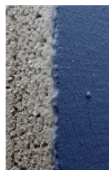
АСО-панели ванных комнат обработаны гидроизоляцией
