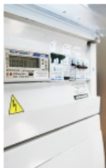
Двухтарифные счетчики и устройства защитного отключения
