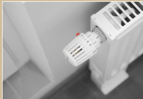
Радиаторы PURMO с терморегуляторами DANFOSS
