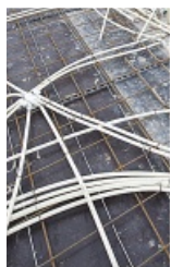
Разводка коммуникаций в толще монолитных перекрытий
