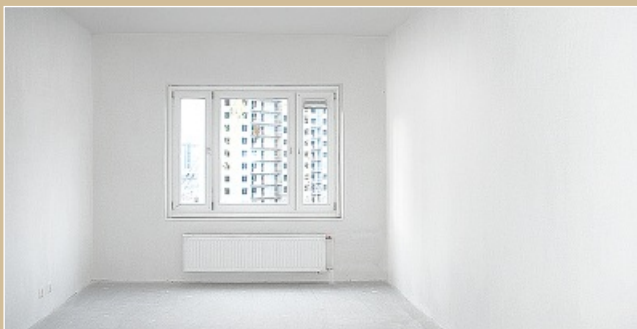
Комната с базовой финской отделкой (полная подготовка под чистовую отделку)
