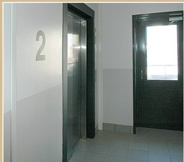
Лестничные клетки облицованы керамогранитной плиткой
