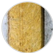
Утеплитель наружных стен из минеральной ваты
