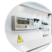
Двухтарифные счетчики и устройства защитного отключения
