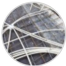
Разводка коммуникаций в толще монолитных перекрытий
