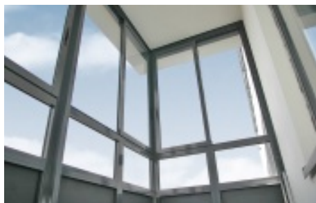
Раздвижные стеклоалюминиевые балконные рамы
