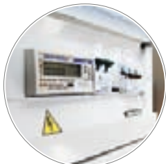
Двухтарифные счетчики и устройства защитного отключения
