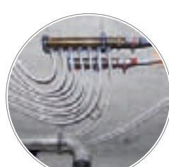
Разводка скрытая, доступ через лючки
