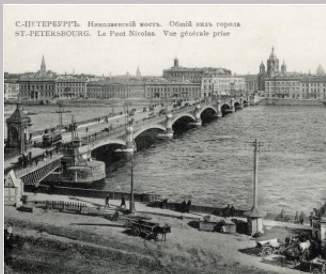
Николаевский (ныне Благовещенский) мост. Первый постоянный мост через Неву.
